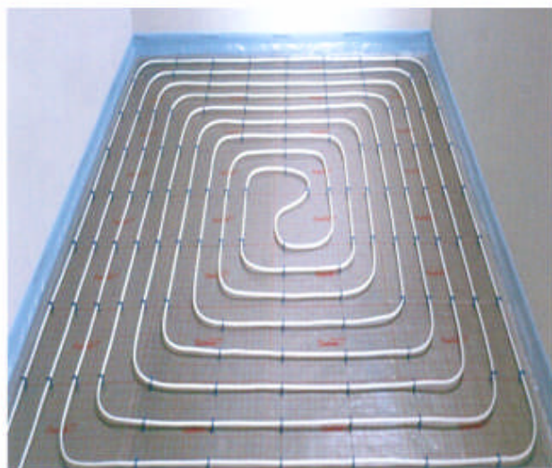
Brugman systemgulvvarme ferdig montert
